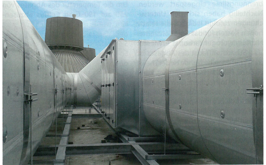
Abfallbehandlung zur Ersatzbrennstoffgewinnung in Zementwerk 45.000m 3 /h, Deutschland
